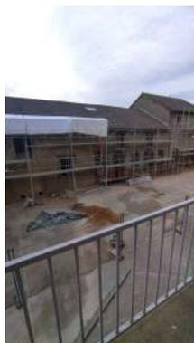
Les travaux de réhabilitation des anciens ateliers en salle multifonction sont désormais bien avancés. La charpente a été renforcée, la toiture refaite, des ouvertures créées et le plancher en béton a été coulé. L'isolation et l'électricité sont en cours. Tout devrait être terminé pour fin août ce qui permettra aux enfants de l'école de retrouver leur cour de récréation.
